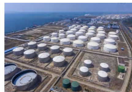
原油储存取巡检
